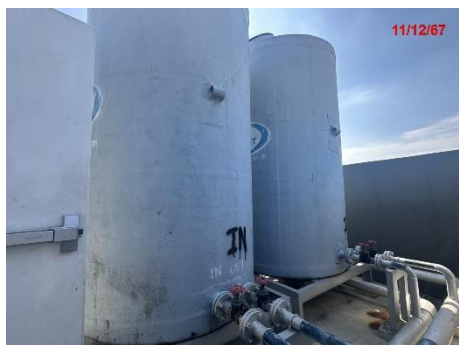
ภาพที่ 2.2-9 ถังเก็บน้ำสำรองชั้นดาดฟ้าและชั้นใต้ดินของโครงการ
