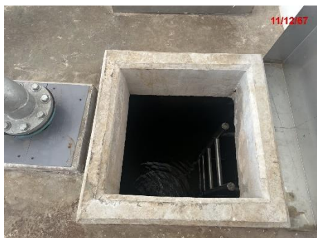
ภาพที่ 2.2-9 ถังเก็บน้ำสำรองชั้นดาดฟ้าและชั้นใต้ดินของโครงการ
