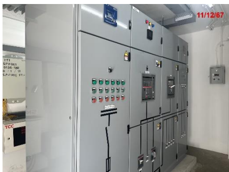
ภาพที่ 2.2-19 ห้องเครื่องไฟฟ้าและหม้อแปลงไฟฟ้าของโครงการ
